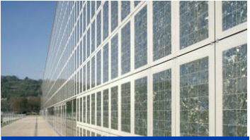
1. PV Roof & Façade
